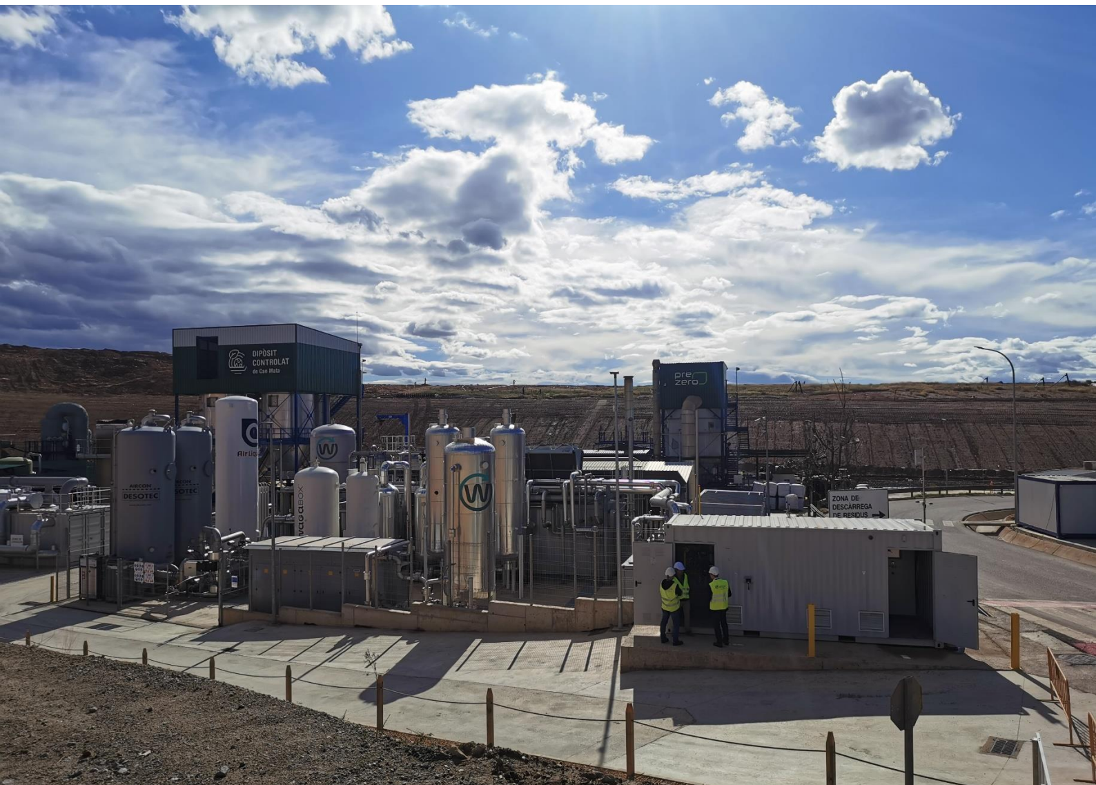
La unidad WAGABOX® para la producción de biometano en el depósito controlado de Can Mata, Cataluña
